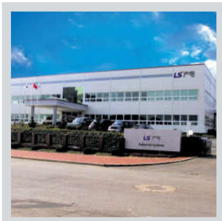
Завод в Даляне (Китай)
